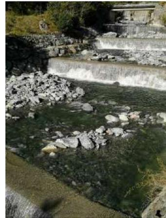
***Vista vasche tra il secondo ponte su tre ed il ponte superiore – proseguendo in direzione monte, il materiale solido depositato aumenta di granulometria – Foto stazione forestale di Verres***
